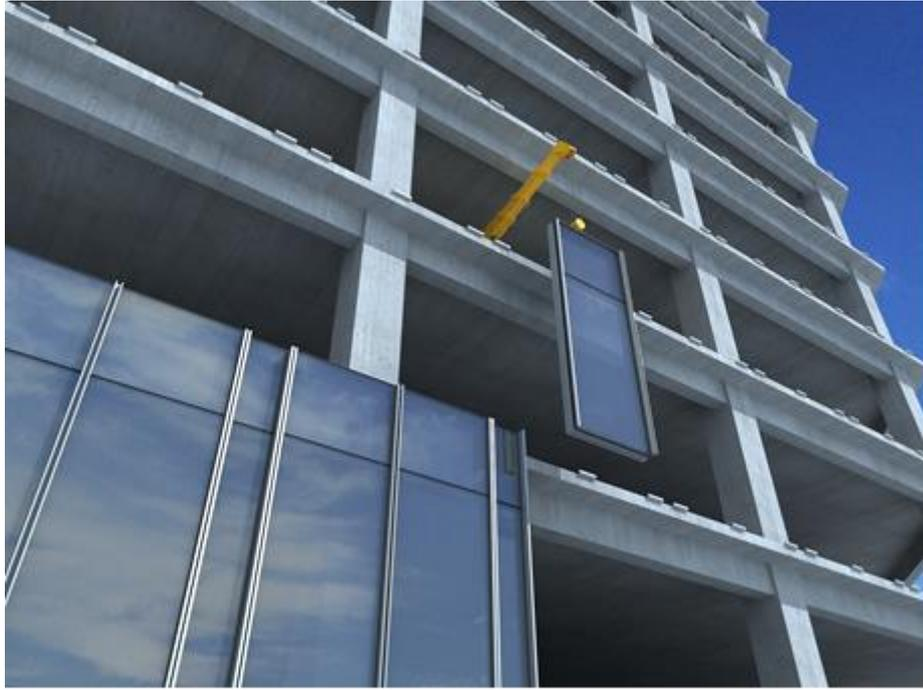
图4 塔楼单臂吊机施工示意图
