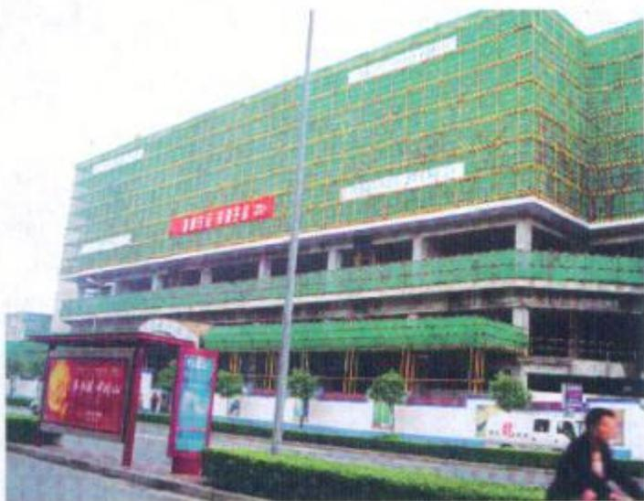
1.根据工程实际编制脚手架专项施工方案,有针对性、有效地指导施工,明确安全技术措施。并经企业技术负责人审批签字盖章后方可实施。其主要内容应包括:基础处理、搭设要求、杆件间距、连墙件拉结点设置、设计计算书、施工详图及大样图安全措施等。
