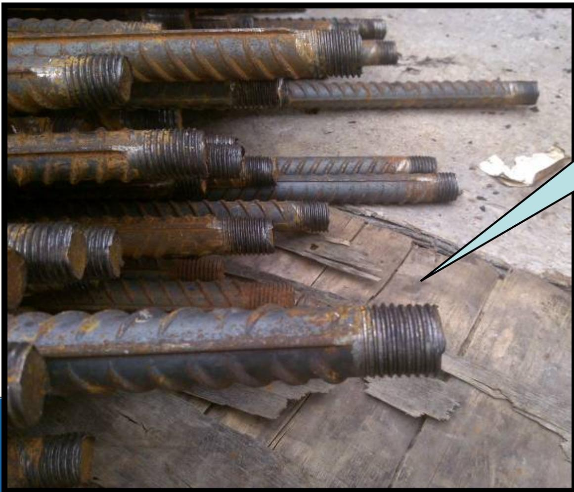
直螺纹加工成型，丝头加工好后，应立即安装好保护套
